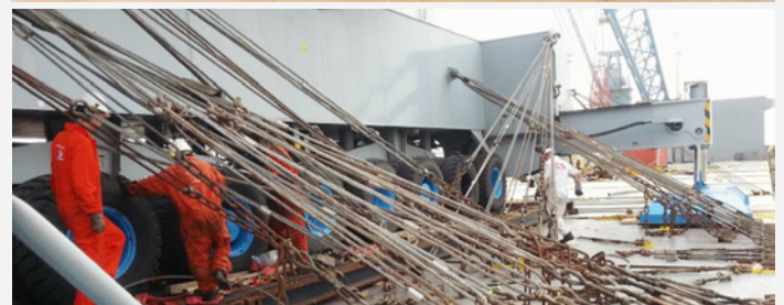
Loading a 520 ton crane
